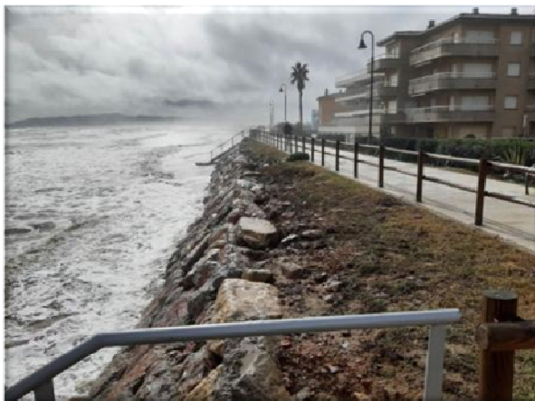
Vista de la escollera longitudinal que protege la urbanización Els Griells, con la playa totalmente cubierta por el agua del mar, así como de las escaleras metálicas que permiten el acceso peatonal a la playa desde el paseo marítimo (Fotografía 17. Anejo 2 del Estudio Técnico)
